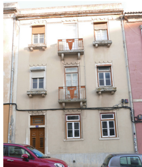
1937/38 Rua Francisco Tomás da Costa, nº 4, r/c
